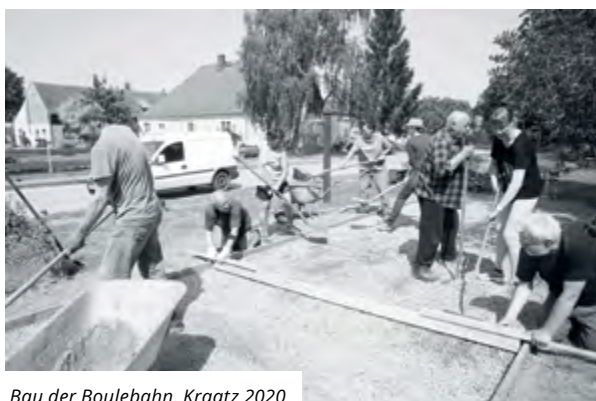
Bau der Boulebahn, Kraatz 2020
